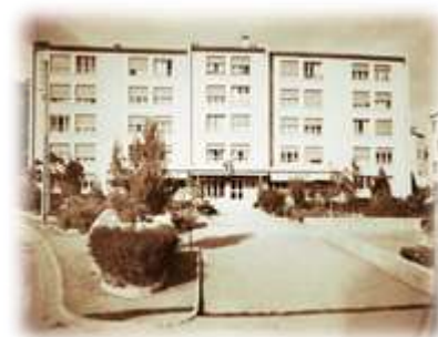
Le Foyer-Logements du Naï en 1977
